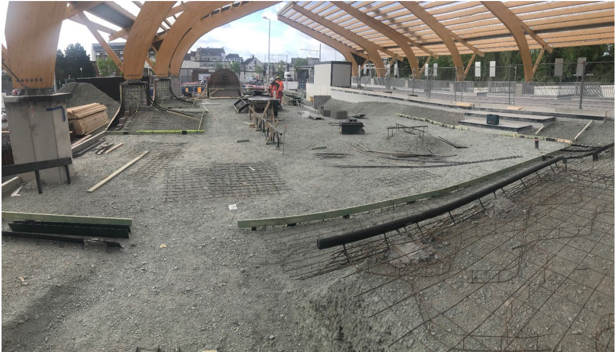
Avancement du chantier (avril-2024)
