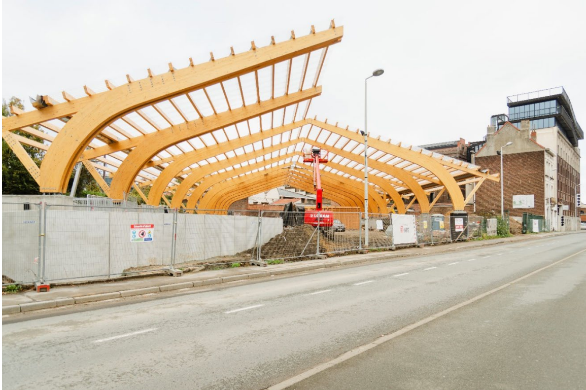
Avancement du chantier côté voirie, Quai F. Demets
